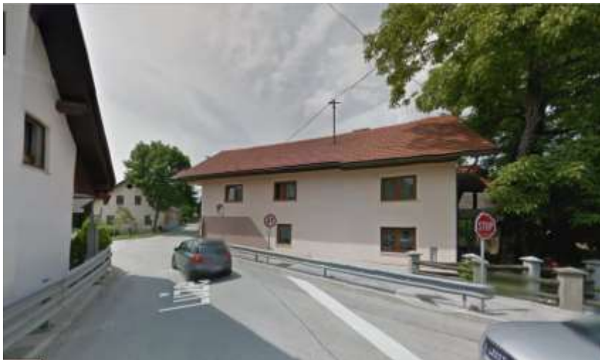
Slika 4: Odsek na cesti Luže – Visoko - Srednja vas je zelo nevaren zaradi nepreglednosti.
